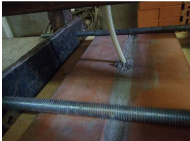
Фото 38. Положение анкера после сжатия в растворе шва. Видно выкрашивание раствора под действием сжатия стержня.
