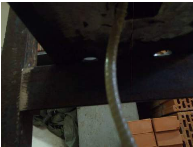
Фото 3. Деформация стержня полимерного анкера после приложения нагрузки.
