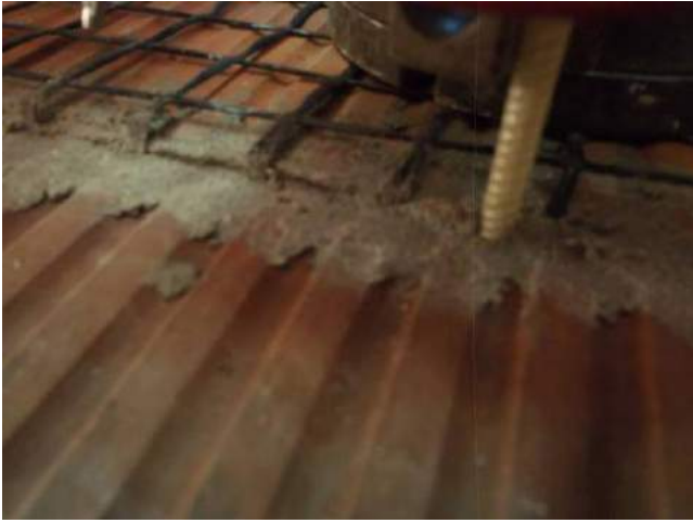
Фото 43. Анкер после испытания. Виден вырыв раствора из шва образца.
