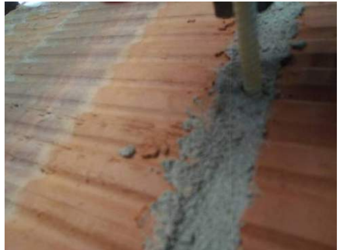
Фото 22. Анкер после испытания. Виден вырыв раствора из шва образца и обрыв наливки полимерного анкера.
