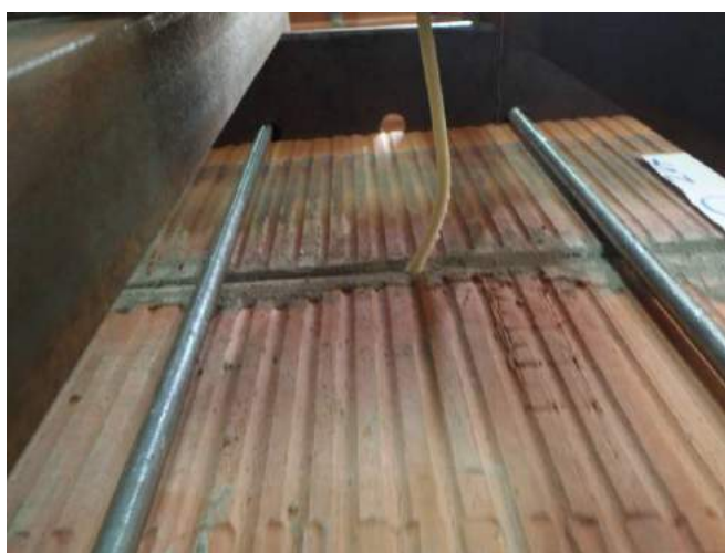
Фото 57. Анкер после испытания. Видим обрыв стекловолоконного шнура полимерного стержня.
