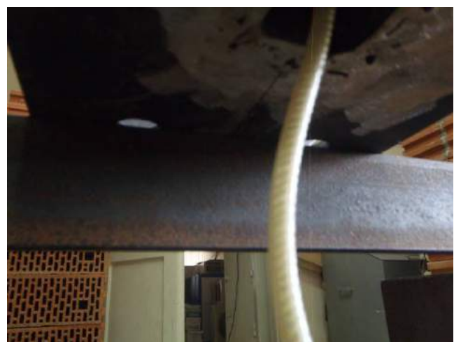
Фото 12. Деформация стержня образца.
