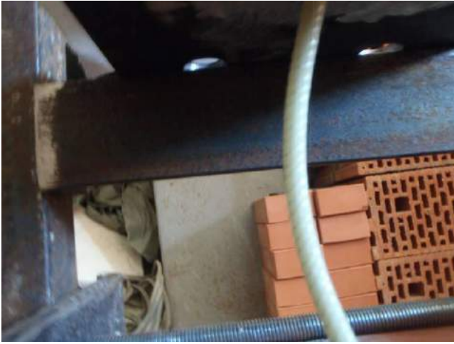
Фото 7. Деформация стержня полимерного анкера после приложения нагрузки.
