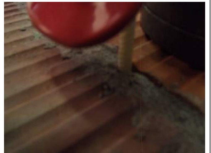
Фото 10. Низ стержня полимерного анкера после испытания.
