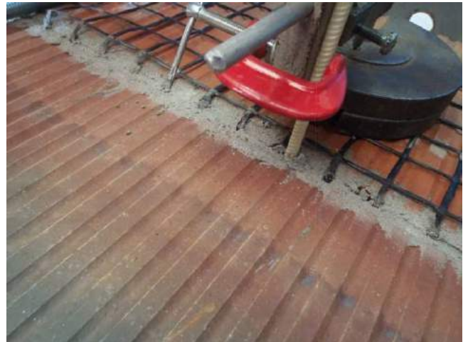
Фото 40. Анкер после испытания. Виден вырыв раствора из шва образца.
