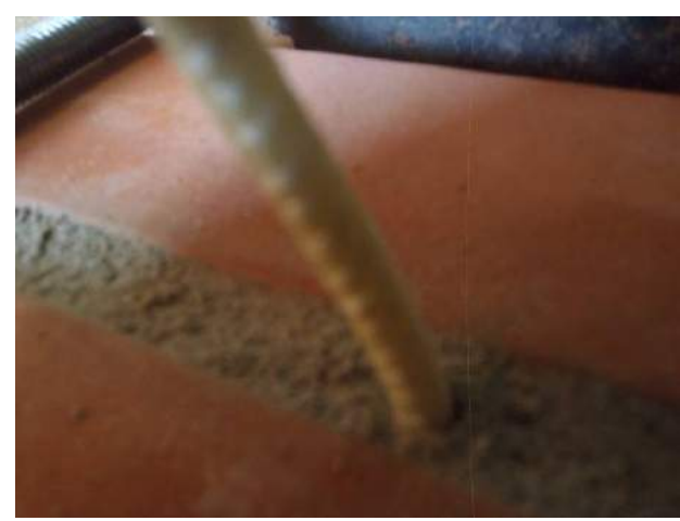
Фото 16. Анкер после испытания. Видно обмятие раствора шва вокруг стержня.
