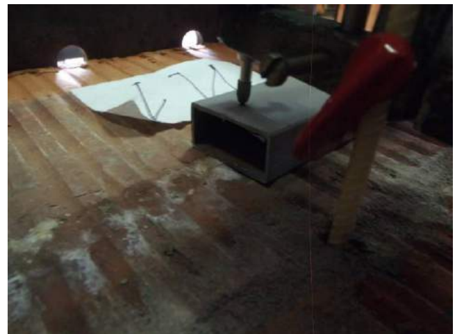
Фото 66. Положение анкера после испытания образца. Видно выкрашивание частиц раствора из шва при вытягивающей нагрузке.
