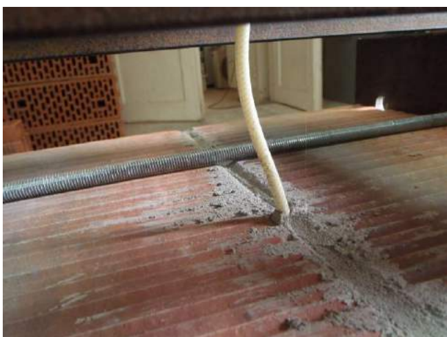
Фото 9. Положение анкера после сжатия в растворе шва под нагрузкой. Видно выкрашивание раствора из шва при сжатии.
