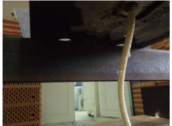
Фото 32. Стержень полимерного анкера после приложения нагрузки (сжатия). На стержне видны обрывы наливки при деформации стержня.
